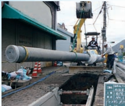
▲ダクタイル鋳鉄管を布設
