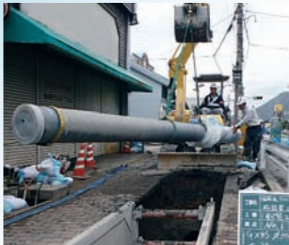
▲ダクタイル鋳鉄管を布設
