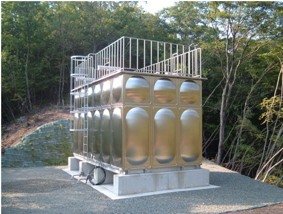
地頭簡易水道大俣第 2 配水池
